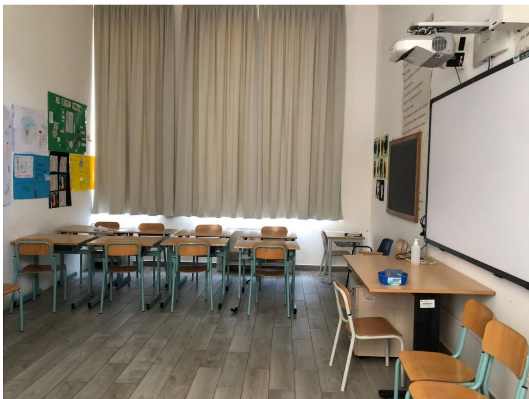
STATO DI FATTO – AULA 5 (PRIMARIA)
